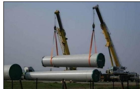
Photo 16 : Manipulation des tronçons d'éoliennes
