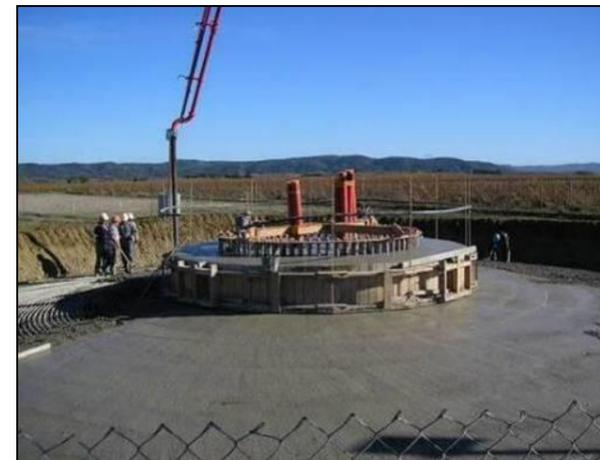
Photo 13 : Coulage du béton
