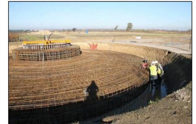
Photo 12 : Ferrailage de la fondation
